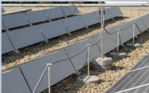
**Äußerer Blitzschutz bei Aufdachanlagen**
